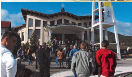
Wiederaufbau mit meinen eigenen Händen: die Wallfahrtskirche in Banja Luka.
