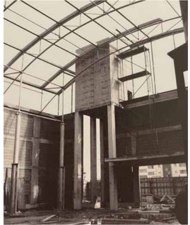
Rohbau der Kirche 1991 (Fotos: Pfarrarchiv).
